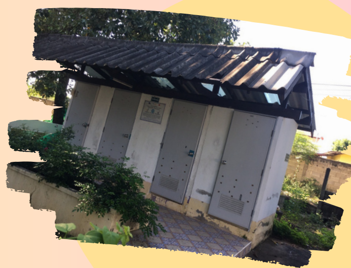
ส้วมจำนวน ๔ หลัง สร้างโดยไม่ใช้งบประมาณของทางราชการ ๒ หลัง และใช้งบประมาณ ๒ หลัง
