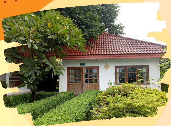
อาคารผู้อำนวยการ จำนวน ๑ หลัง (สร้างโดยไม่ใช้งบประมาณ ของทางราชการ)
